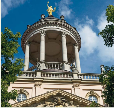
Unter königlichem Dach: Das Militärwaisenhaus in Potsdam.
