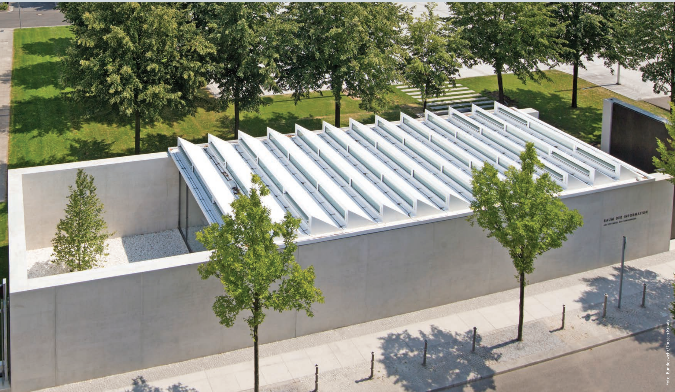
Blick auf die Hainbuche und das sogenannte „Sheddach“ des Raums der Information, das einen gleichmäßigen Lichteinfall und eine größtmögliche Helligkeit im Innenbereich des Gebäudes sicherstellt (gesehen aus der Luftperspektive Hildebrandstraße).
