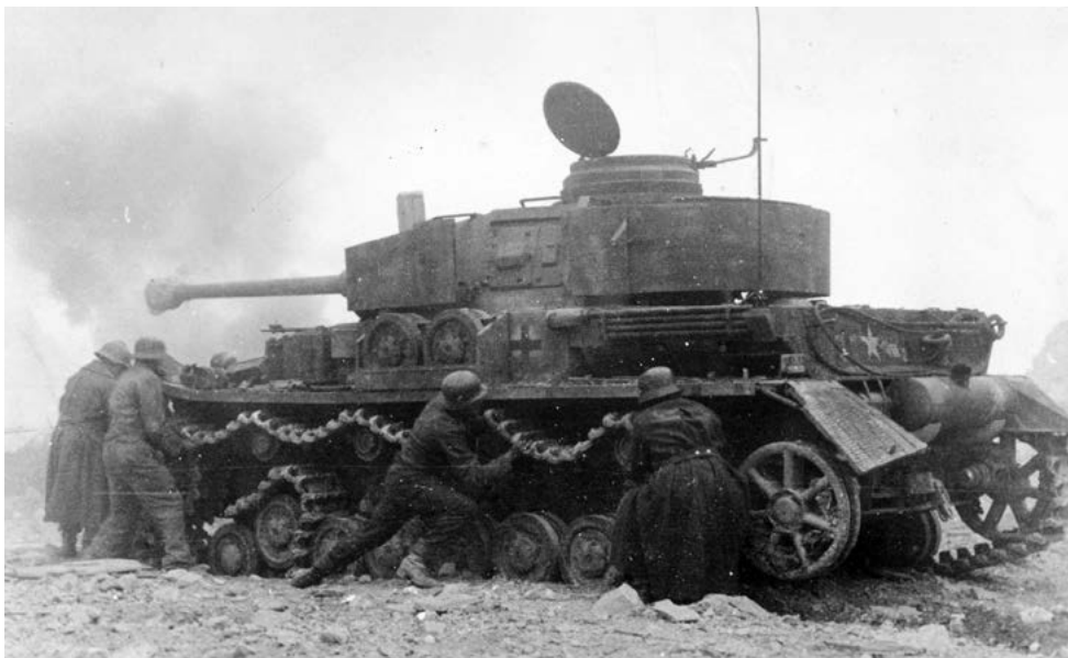
Materialschlacht: Die Besatzung eines Panzerkampfwagens IV der 15. Panzergrenadierdivision zieht im Ortskern von Cassino die heruntergelaufene Kette wieder auf, März 1944.
