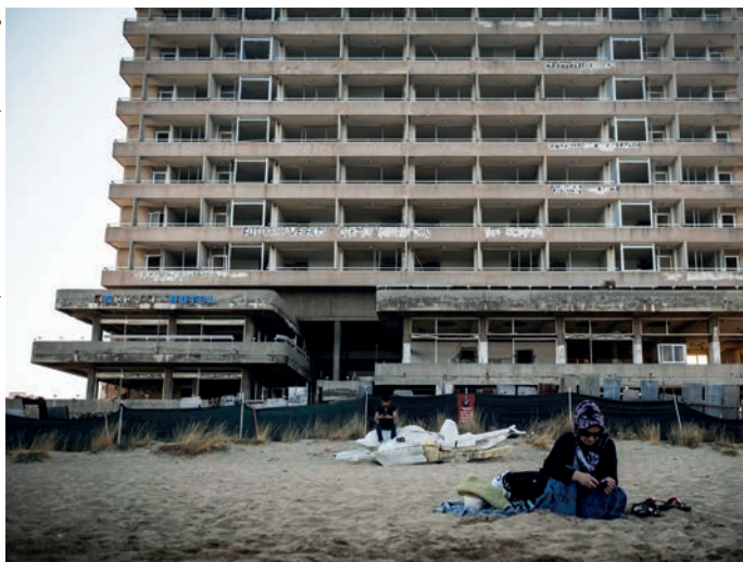
Blick auf ein Gebäude der verlassenen »Geisterstadt« Varosha (Vorort von Famagusta). Vor der Teilung der Insel war dieser Ort eine prosperierende Touristenmetropole.
