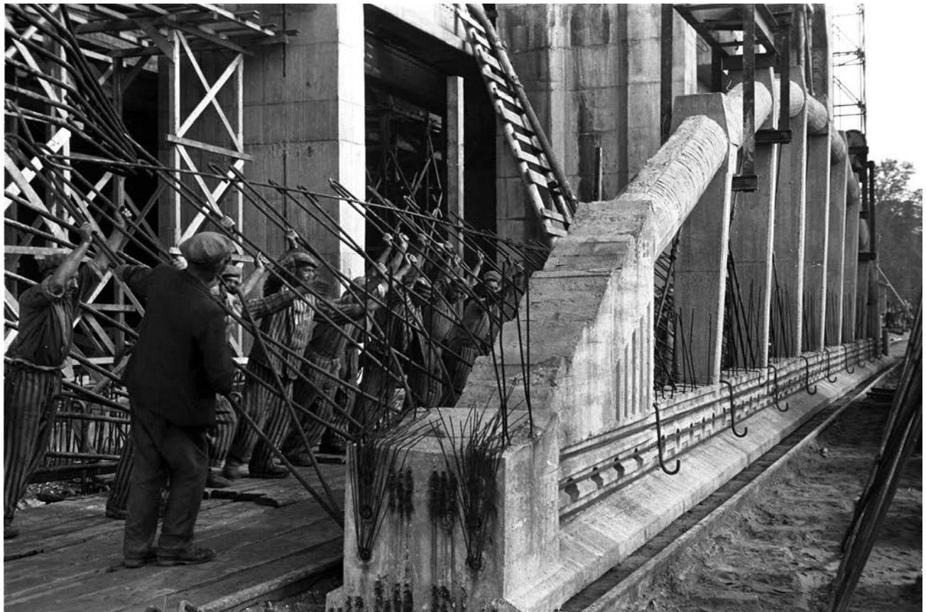
▲ Prisioneros de un campo de concentración usando barras de hierro para colocar un arco de hormigón pretensado sobre el lugar de construcción del búnker para submarinos «Valentin».
